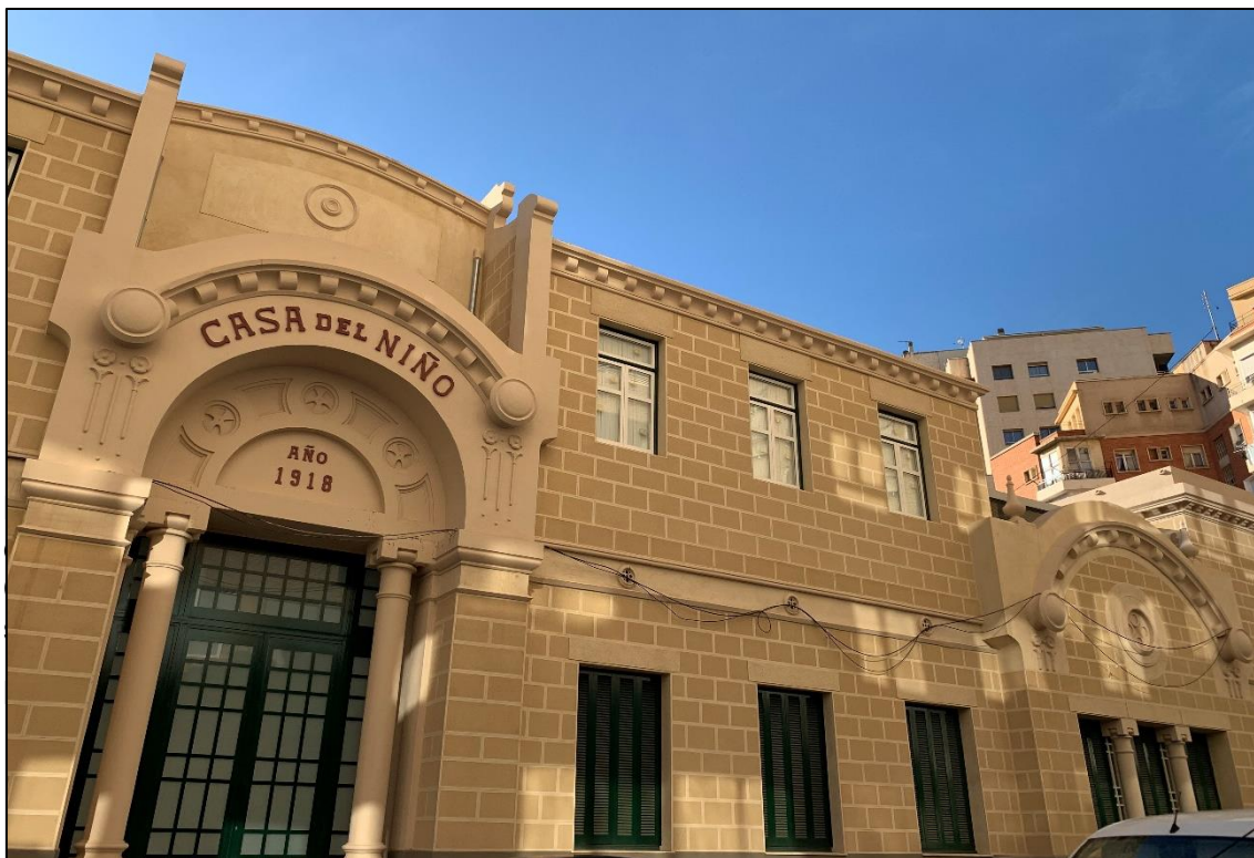
Fachada principal del edificio
